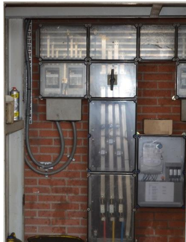
Afbeelding 3: Halvaster paneel met actieve, niet-aanrakingsveilige delen achter deksels
